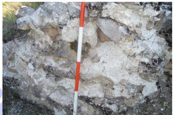
Fig.11- pamje e vrimës së skelerisë së ndërtimit . Fig. 12-trakt i murit të një godine brenda citadelës
