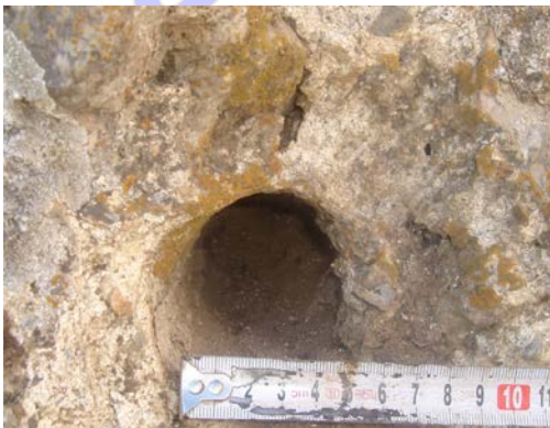
Fig.11- pamje e vrimës së skelerisë së ndërtimit . Fig. 12-trakt i murit të një godine brenda citadelës
